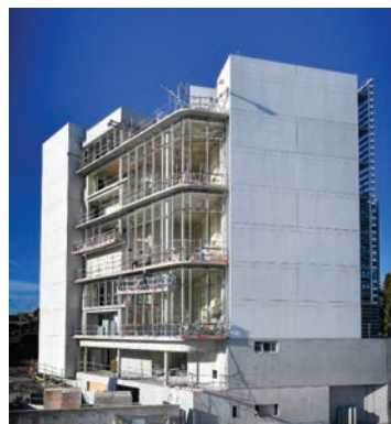
i.active ULTRA de Ciments Calcia s'adapte parfaitement à la réalisation de panneaux architectoniques préfabriqués comme ceux mis en œuvre sur la façade de la Maison de la Corée.
